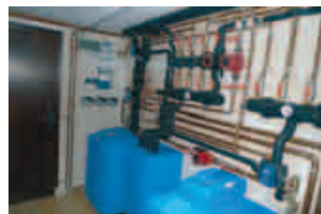
Ogrevanje prostorov (radiatorsko) in bazena + pasivno hlajenje preko konvektorjev
