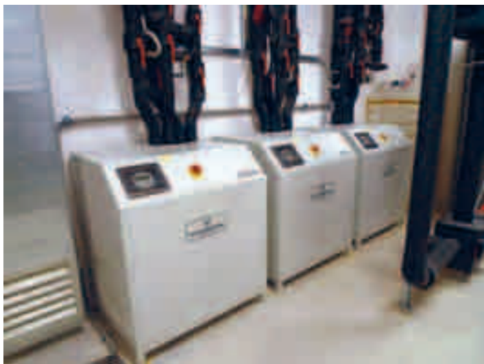
Ogrevanje in hlajenje proizvodnih in pisarniških prostorov
